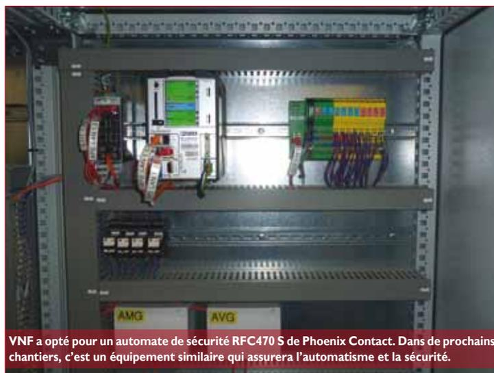
VNF a opté pour un automate de sécurité RFC470 S de Phoenix Contact. Dans de prochains chantiers, c'est un équipement similaire qui assurera l'automatisme et la sécurité.
