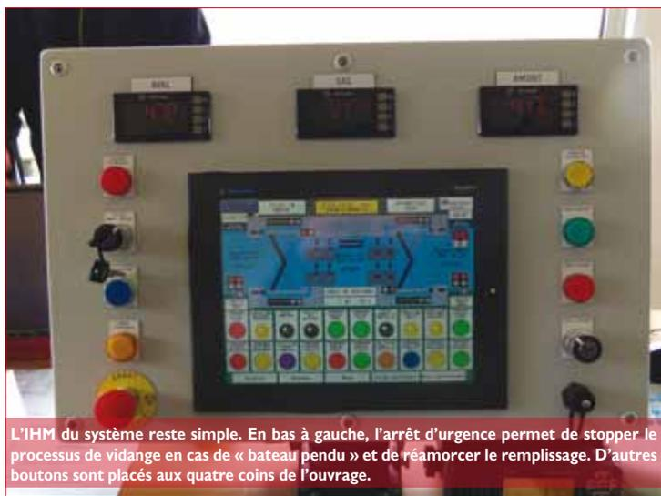
L'IHM du système reste simple. En bas à gauche, l'arrêt d'urgence permet de stopper le processus de vidange en cas de « bateau pendu » et de réamorcer le remplissage. D'autres boutons sont placés aux quatre coins de l'ouvrage.
