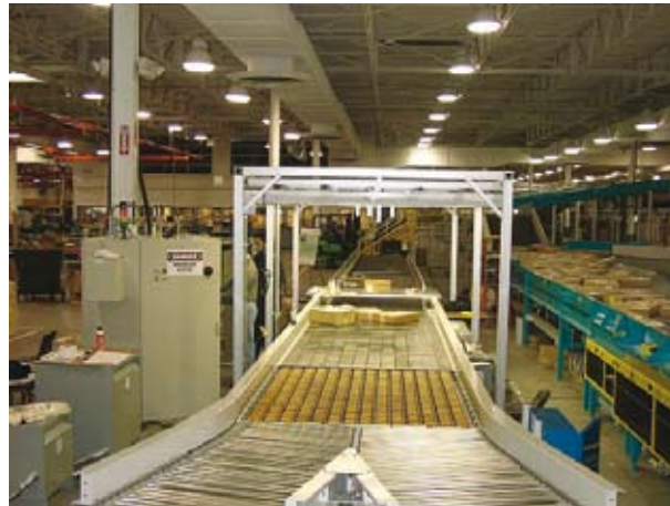
Figure 8 : Sur le prototype physique, on voit un ensemble de paquets situés à l'entrée du séparateur. La structure surmontant l'installation est équipée de six caméras utilisées par le système de vision temps réel.
