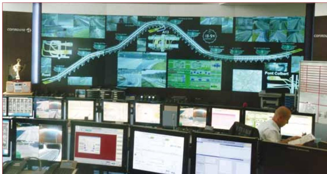
Le poste de contrôle et de surveillance regroupe toutes les informations nécessaires à l'exploitation du tunnel.
